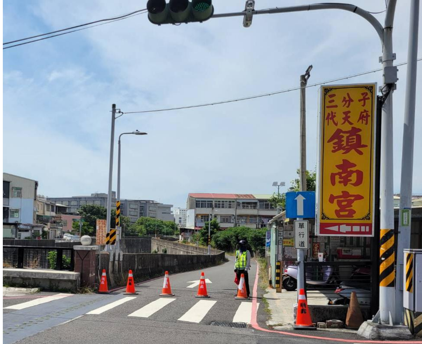
防汛道路封閉處：北園街124巷10弄 請向在場施工單位交通指引人員表明是“聖功女中家長”的身份，即可開放行駛防汛道路。
